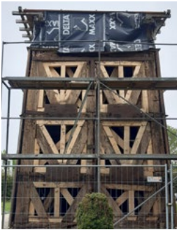
Westansicht des Glockenturms in Böklund: Schaftgerüst mit provisorischen, lastabtragenden Hölzern
